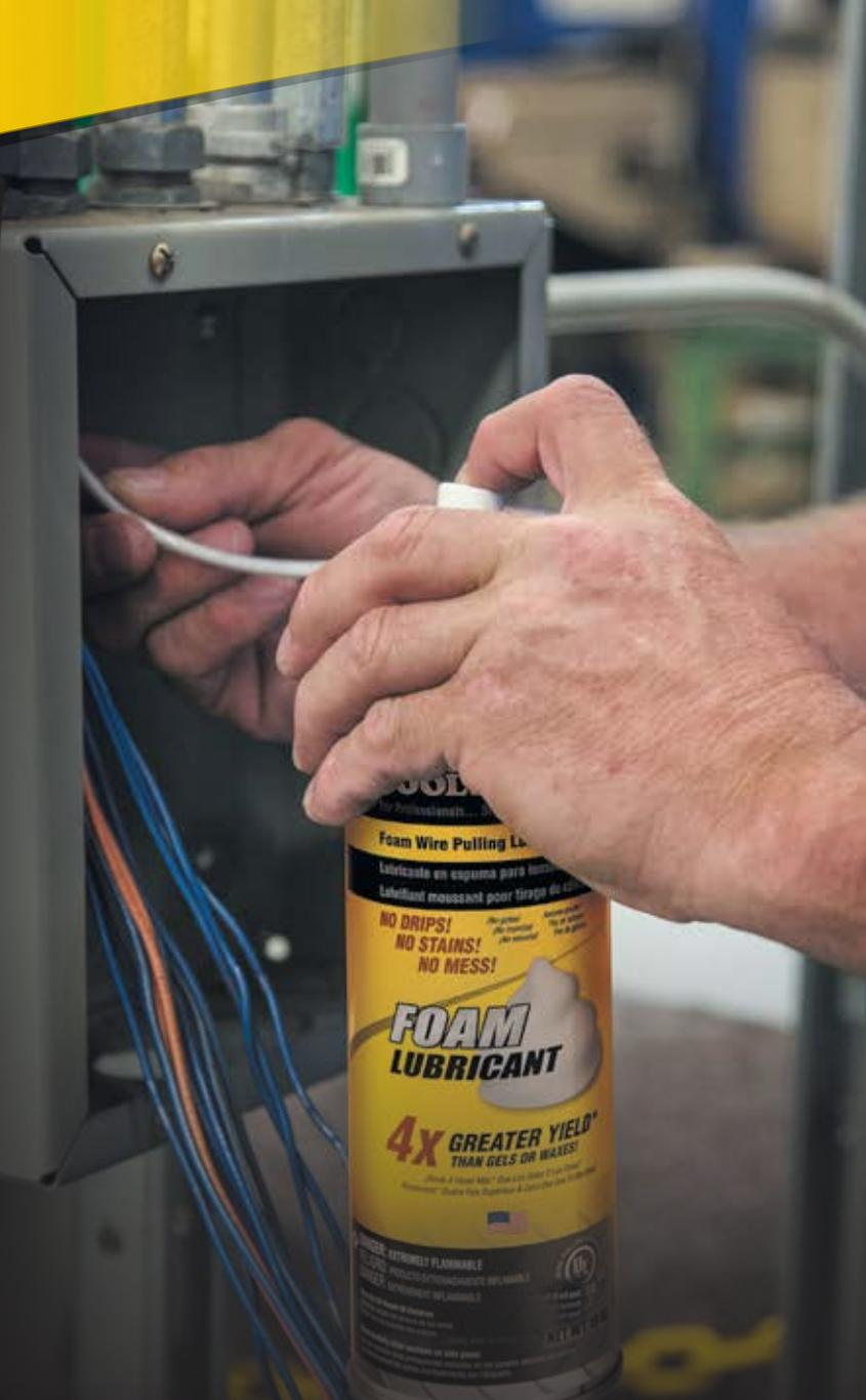
Lubricante en espuma para tensado de cables
