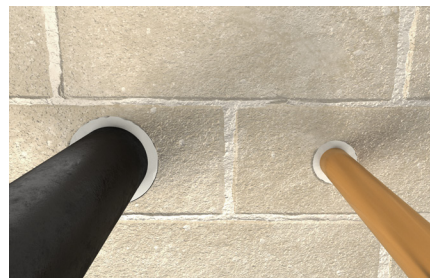
Tubería de servicios
